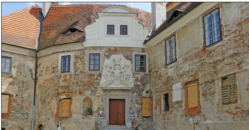
Hlavní vstup do zámecké budovy s opraveným štítem a erbem rodu Coudenhove-Kalergi
