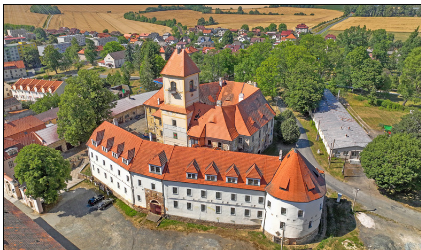
Celkový pohled na zámek s jižním křídlem v popředí
