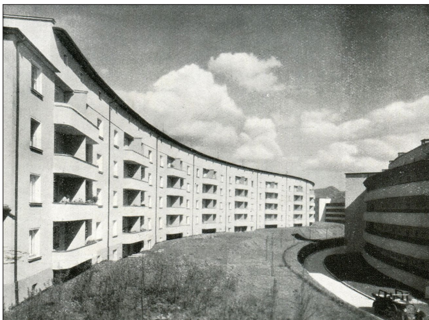
Dobový snímek z roku 1932 zachycující dokončenou třetí etapu progresivních pavlačových domů
