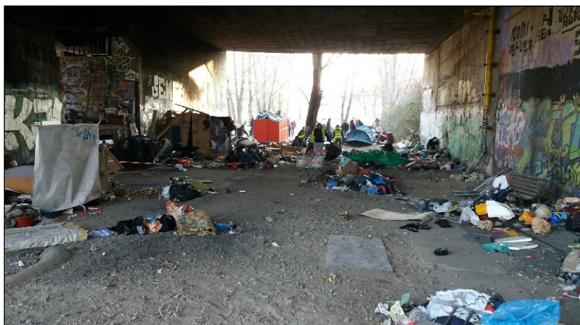
Situace pod mostem Barikádníků před vyklizením
