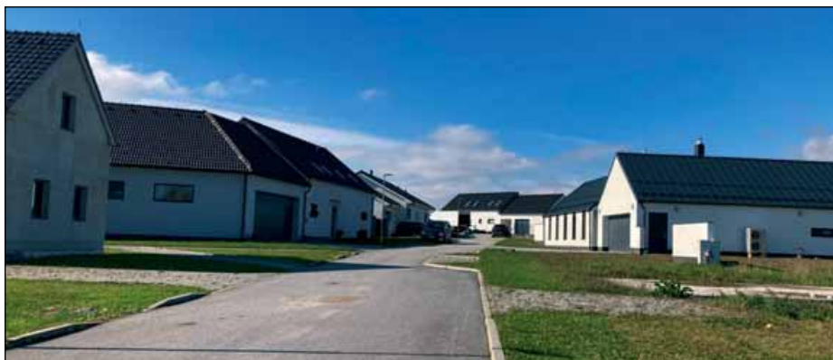
Nově vznikající zástavba na ploše řešené územní studie Mirkovice
