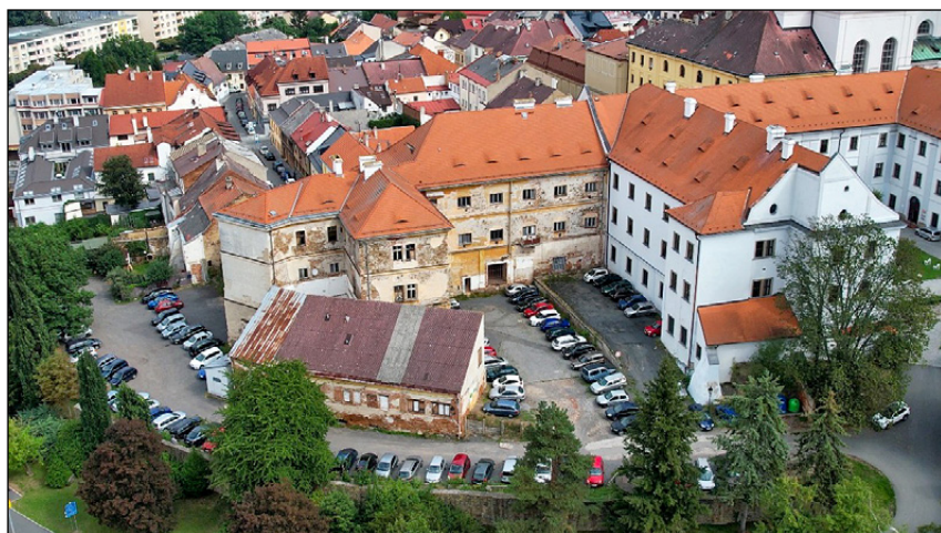
Komplex budov bývalé jezuitské koleje – současný stav
